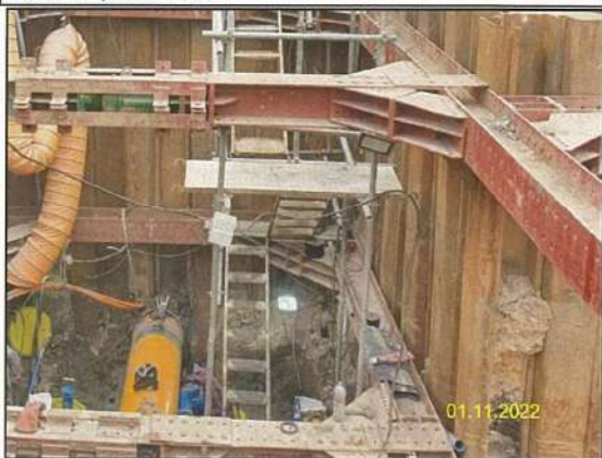
ง) งานวางท่อโดยวิธีดันลอด (Boring)
