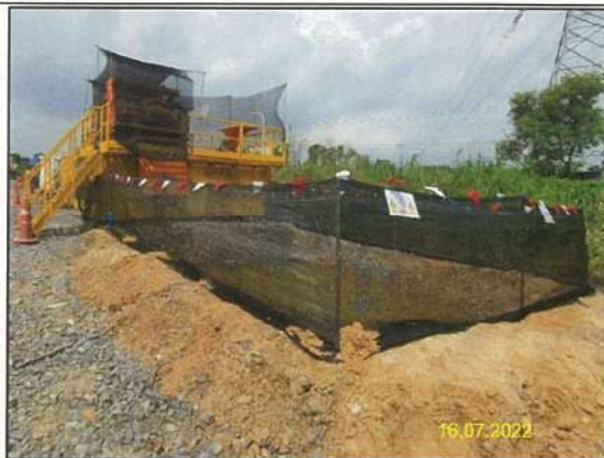
ค) การวางท่อโดยวิธีเจาะลอด (HDD)
